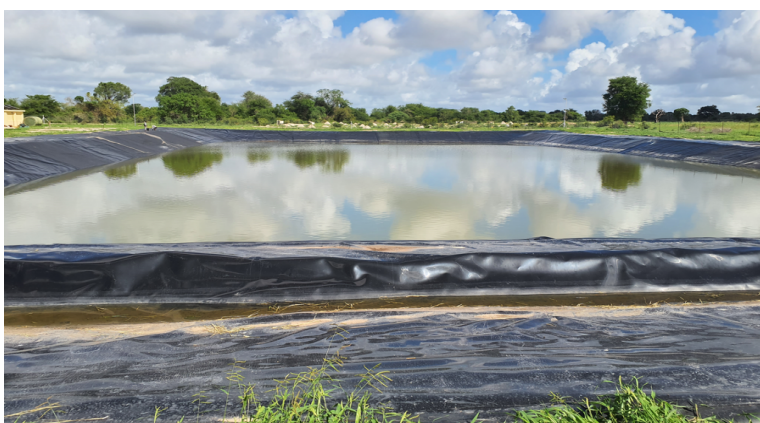
Figura 3: exemplo de reservatório escavado-Fonte: Archer Dete
