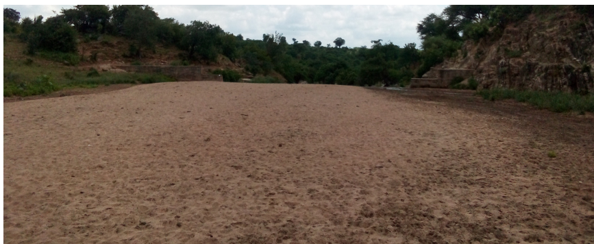
Figura 4: Barragem de areia-Fonte: Faife, Celsio Luís – ARA-Centro
