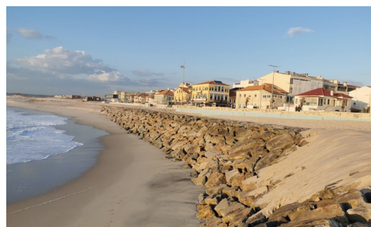
Fig. 15 – Enrocamento visível, Furadouro, Portugal (Helena Pinho, 2022).
