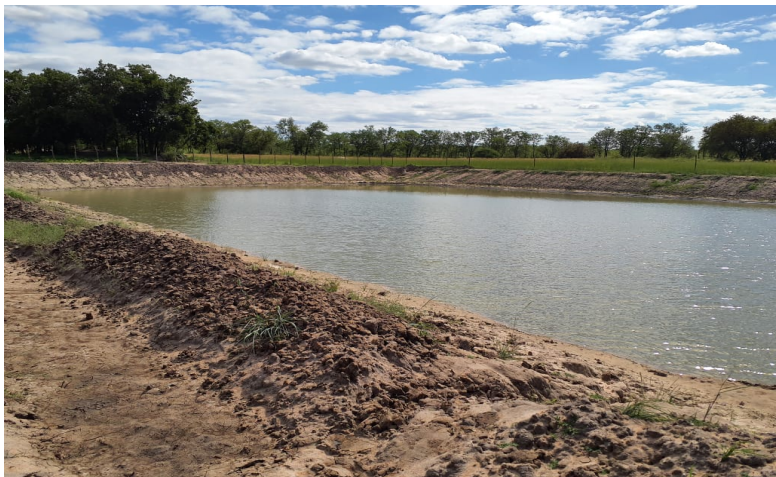
Reservatório de Machaila
