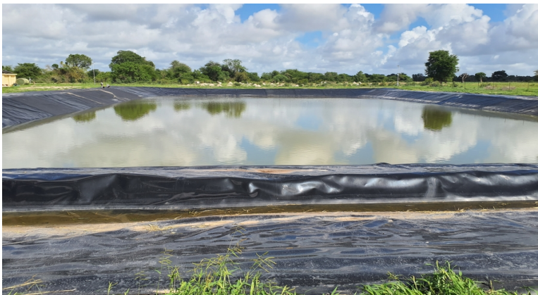
Reservatório de Mucuíne
