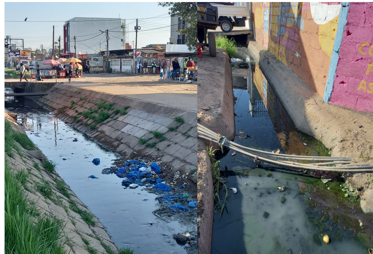
Vala da Avenida de Angola
