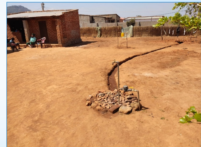
Torneira de quintal e drenagem
