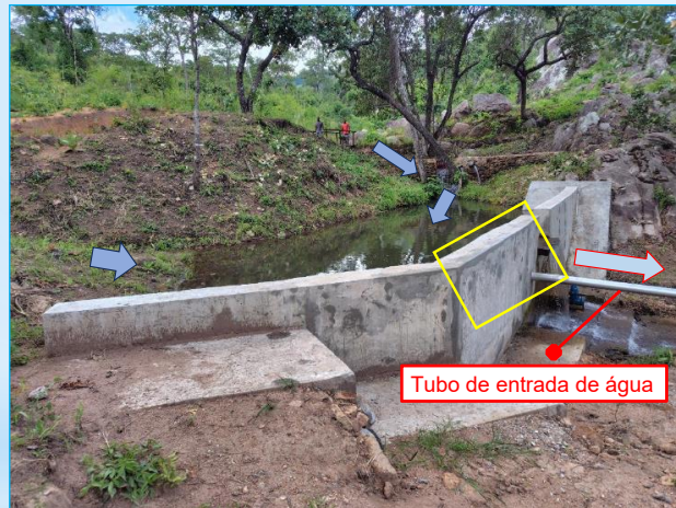
Açude de captação
