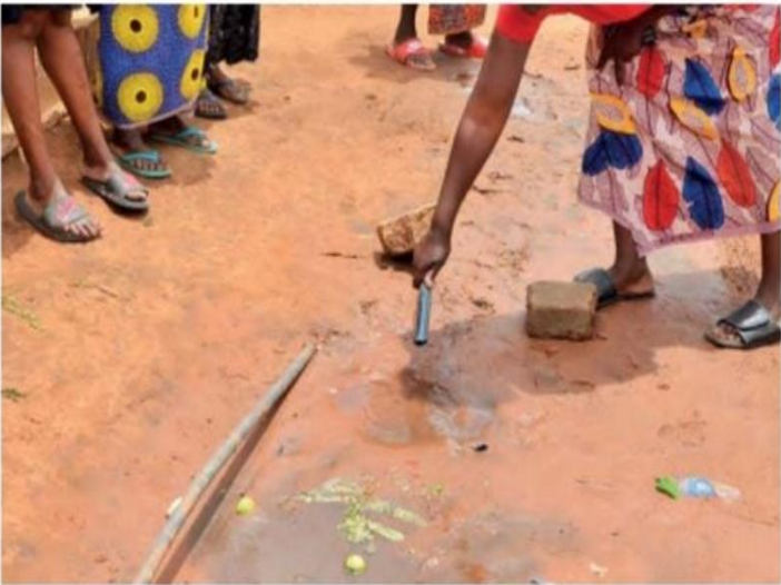
Vandalização de tubagem é uma das principais causas da perda de água
