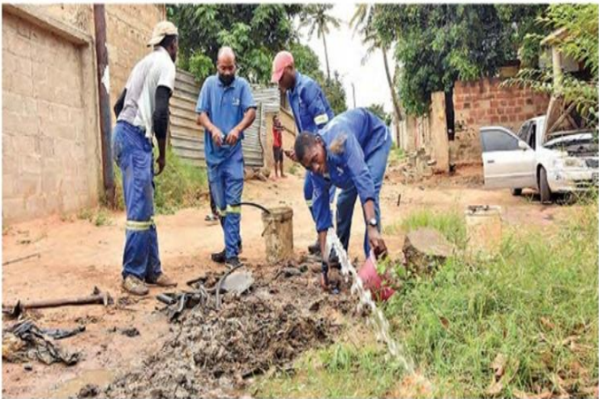
Desmantelamento de ligações de água clandestinas
