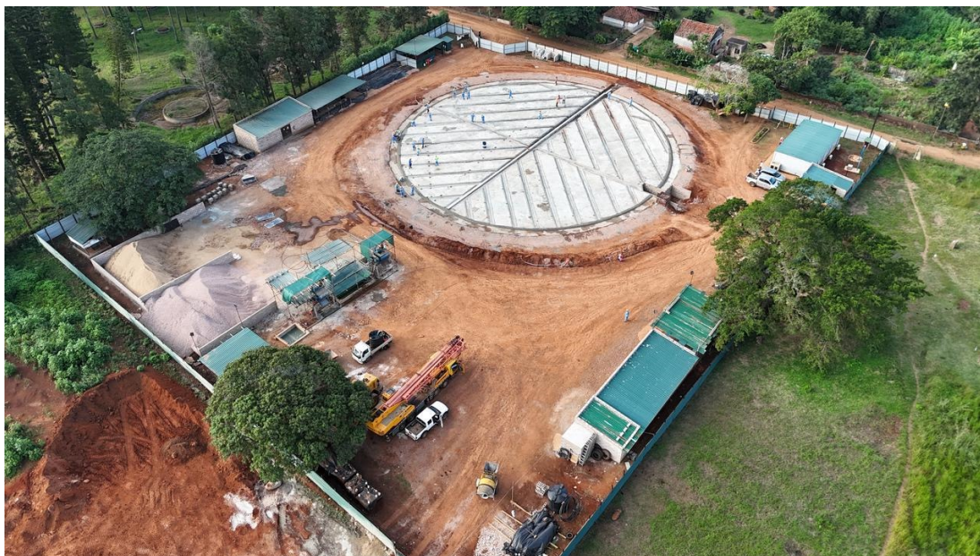
Depósito em construção
